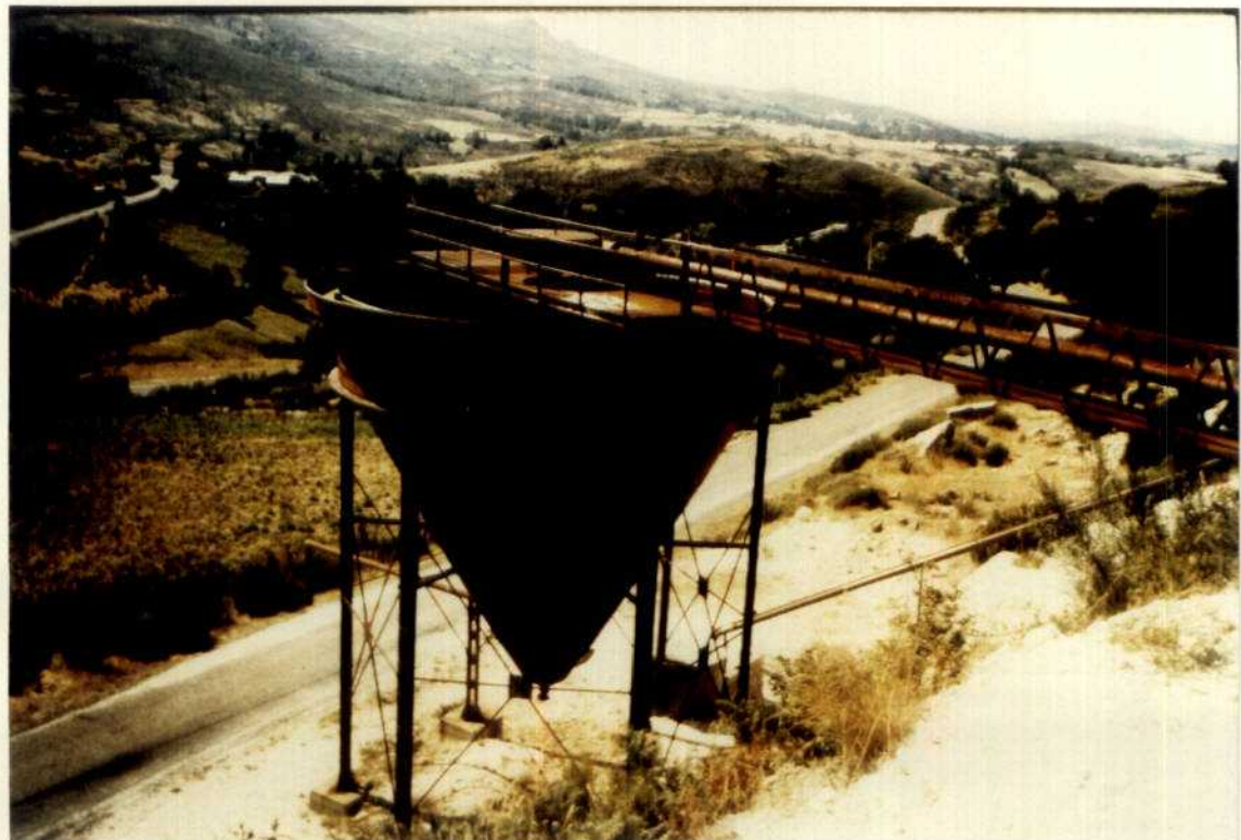
Fotografía-10: Cono de decantación de lodos
