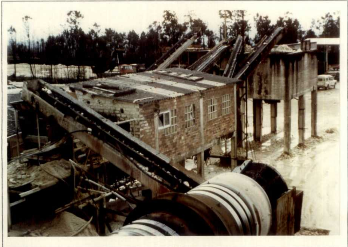
Fotografia-5: Salida del tromel a la nave de estrió manual
